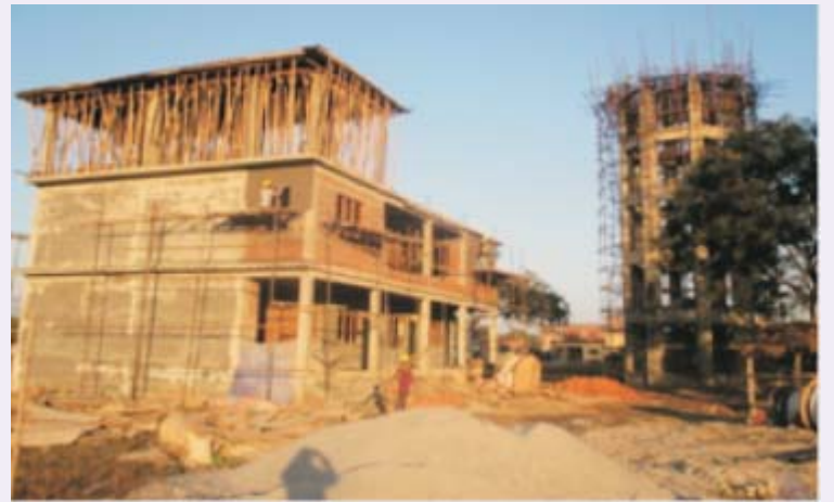
निर्माणाधीन ओभरहेड ट्याङ्की तथा अफिस (टिकापुर, कैलाली)
