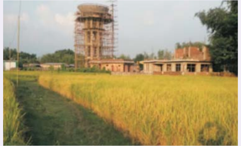
निर्माणाधीन ओभरहेड ट्याङ्की (चारआली, भूपा)
